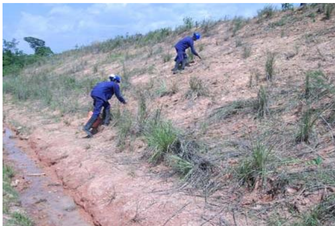
Figura 5.2 – Técnica de Semeadura Direta
